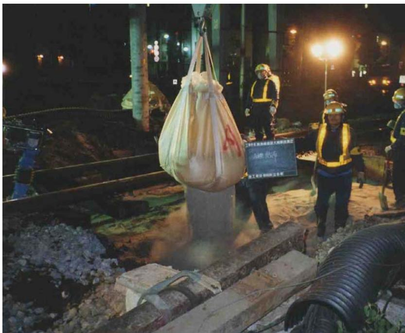
新バンナビーは、透水性が大きく比較的作業困難な場所においても簡便かつ短時間で高支持力の路盤に置き換えることができる透水性路盤材です。
